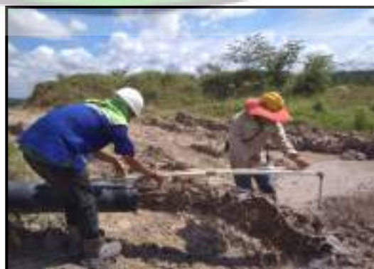
Gambar 4.6 Pengukuran Debit Pompa menggunakan Flowbar dan metode Discharge
